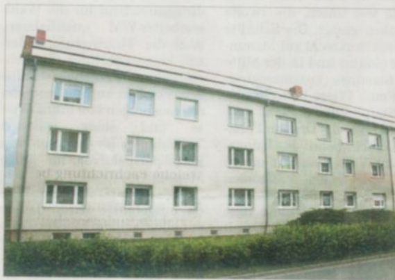
Auf dem Dach des Mehrfamilienhauses Burkhardstraße 13 bis 17 in Triptis betreibt die Wohnungsgenossenschaft Pöbneck eine ihrer vier 25-kW-peak-Photovoltaikanlagen.
